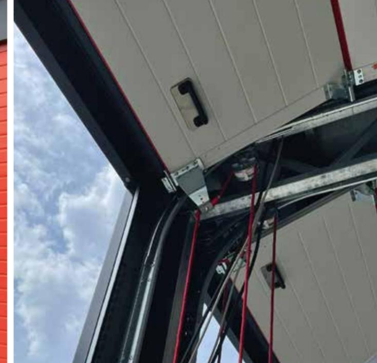
Einfaches System für die manuelle Öffnung der Tore, die mit einem Fingerklemmschutz und einem Bodenabschlussprofil mit Gummidichtung versehen sind.
