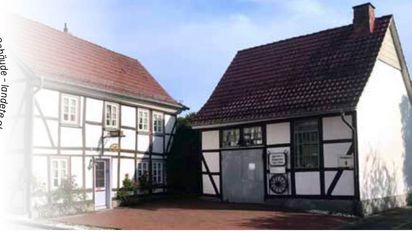
Schutzwürdiges Ensemble aus Wohnhaus und Werkstatt der ehemaligen Freeterschen Schmiede. Foto H. O. Arnold
